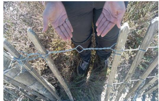
Figure 56 : Réparation des ganivelles au niveau du chemin menant au phare de la Gacholle
